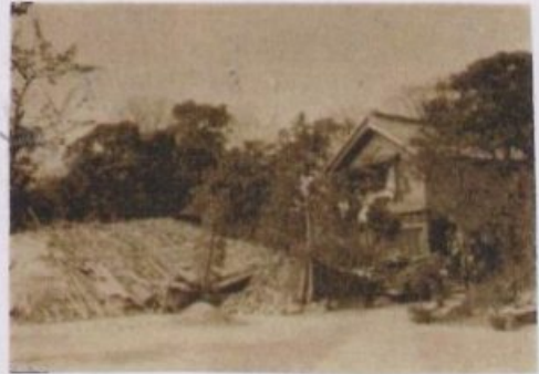
関東大震災の被害
