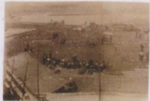
昭和始めの佐是堰改修工事
